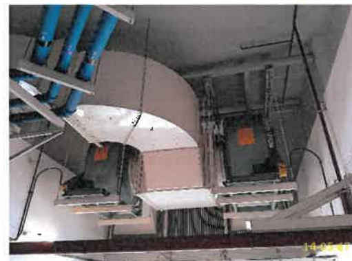
พัฒนาระบายอากาศที่จอดรถ การระบายอากาศโดยวิธีกล (ต่อ) ภาพที่ 1.3.10-1 (ต่อ) ระบบระบายอากาศ
