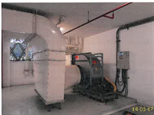
พัฒนาระบายอากาศที่จอดรถ การระบายอากาศโดยวิธีกล (ต่อ) ภาพที่ 1.3.10-1 (ต่อ) ระบบระบายอากาศ
