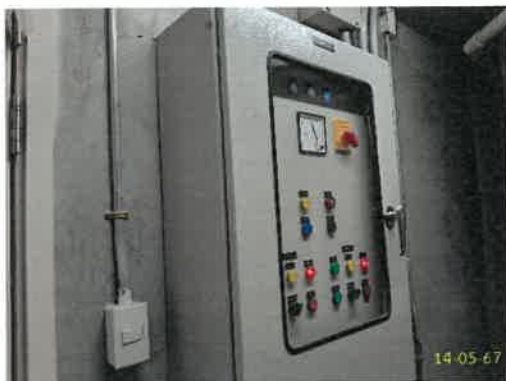
บ่อน้ำ และตู้ควบคุม ชั้นใต้ดิน ระบบระบายน้ำฝนภายในอาคาร ภาพที่ 1.3.6-1 การระบายน้ำของโครงการ
