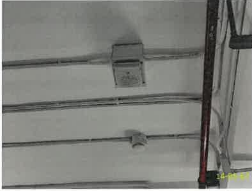
อุปกรณ์ส่งเสียง และแสงสัญญาณแจ้งเหตุ
